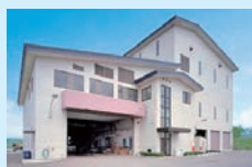
粗大ごみ処理施設 延命化工事 令和2年度開始
