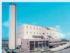
ごみ焼却処理施設 延命化工事 (令和元年度分) 5億2,326万円
