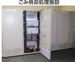
中央操作室DCS設備改良工事 6,588万円
