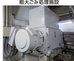
粗大ごみ処理施設 回転式破砕機用電動機等更新工事 4,914万円
