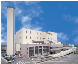
ごみ焼却処理施設修繕工事(OH) 1億2,424万円
